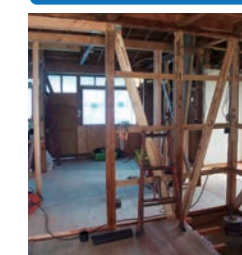
筋かいなどを設置
